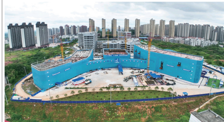
项目建设现场。
