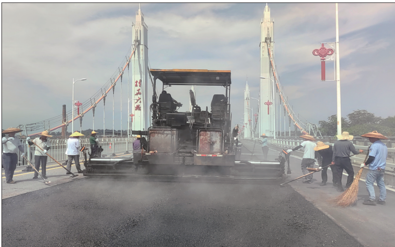
6月6日,本报报道了桂花桥桥面破损严重,给行车带来安全隐患。看到报道后,相关部门很是重视,积极协调处理。6月15日,邵阳盛邦沥青混凝土有限公司对破损桥面进行修补。6月16日,修补工作全部完成。图为6月16日上午,工人们正在进行沥青摊铺作业。
