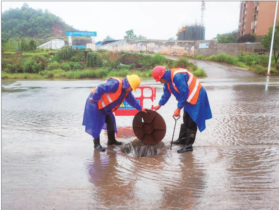
6月8日,市区桃源路因强降雨出现道路积水。当日,市市政维护事务中心工作人员迅速出动,携带抽水泵、疏通杆等专业设备开展作业。图为工作人员采取揭雨水井等方式,加速积水消退。
