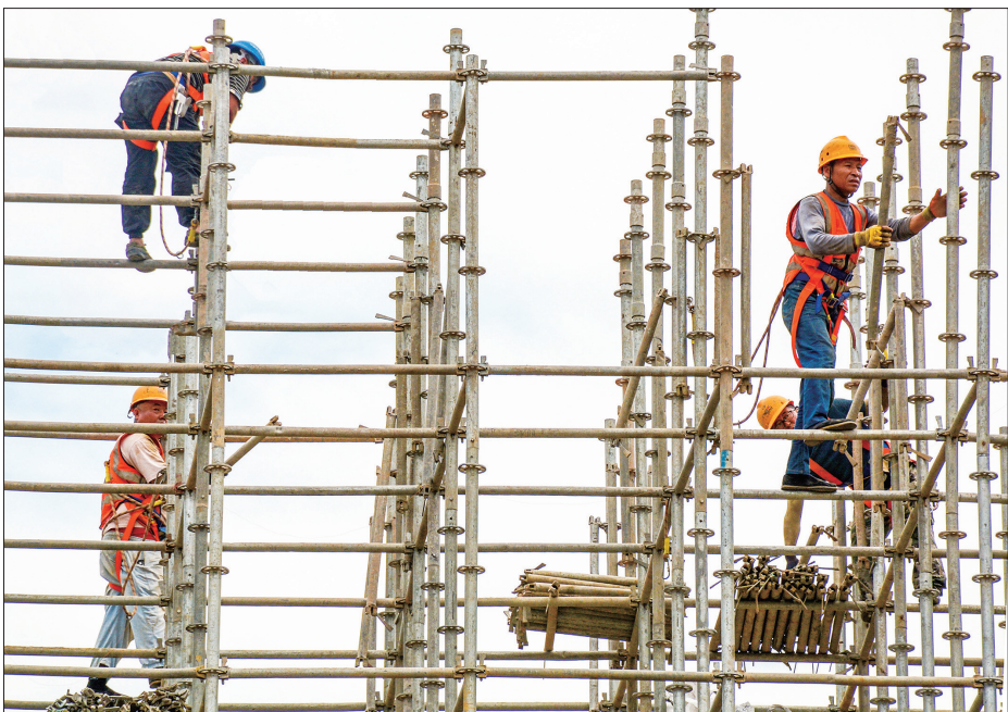
6月4日,在新宁县金石镇永安村新新高速公路二标段3工区,工人在高空中进行引水渡槽钢管架施工作业。当前,该项目横跨路面的引水渡槽钢管架施工基本接近完成,6月底有望竣工通车。郑国华 邓喧喧 摄影报道
