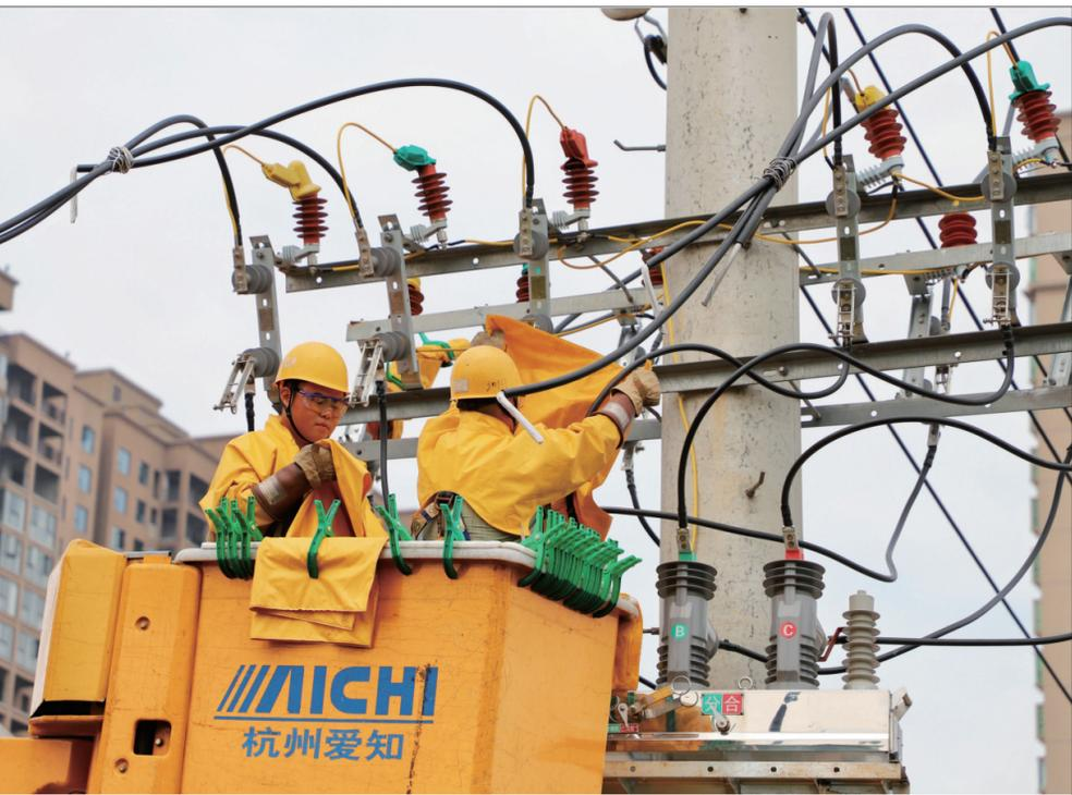
6月3日,为确保高考期间安全稳定可靠用电,国网新邵县供电公司涉及高考考点10千伏柳沙、柳镇线大坪支线P04号杆临时过渡施工工程开展带电作业,彻底消除该处安全隐患,为新邵县广大高考学子安心、舒心用电提供了强有力的“满格电”保障。
