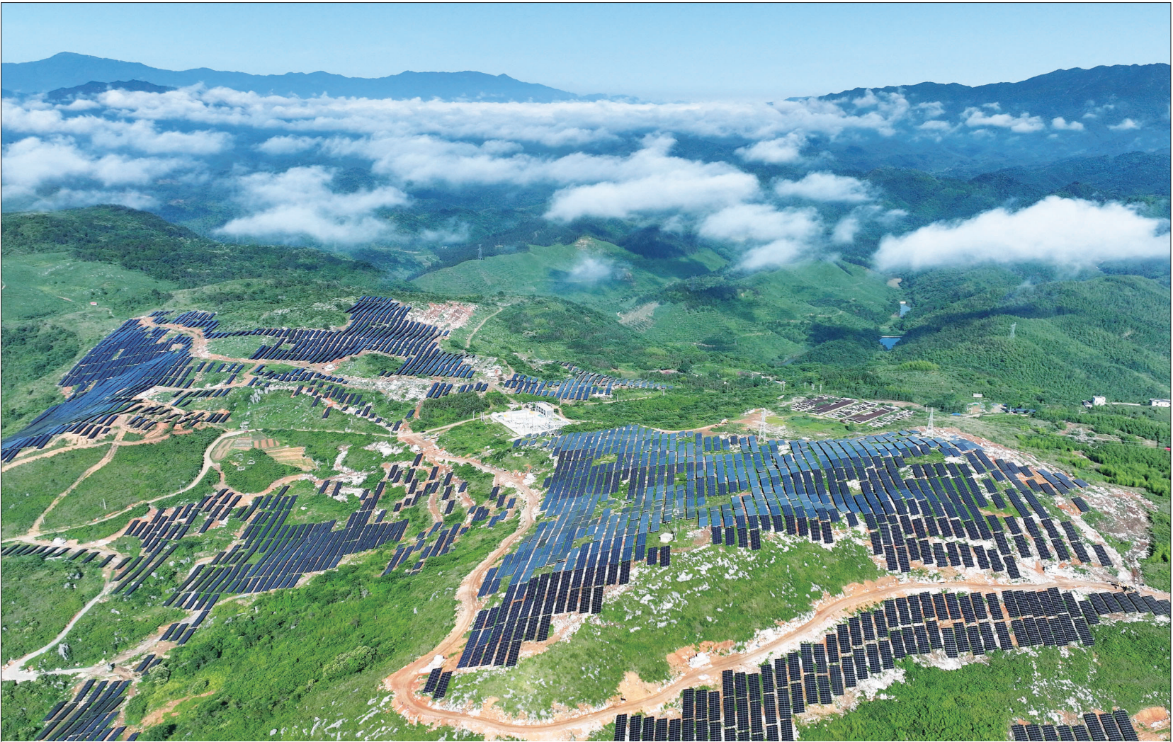
5月26日,俯瞰建设中的城步苗族自治县西岩镇落水发电项目一期工程,遍布山岗的光伏发电板与萦绕低空的云雾、绵延起伏的群山交相辉映。该项目总投资4.5亿元,装机规模9万千瓦,跨城步西岩、茅坪和土桥农场管理区三个乡镇场,分一期、二期建设,2023年6月开工,计划今年底竣工。
