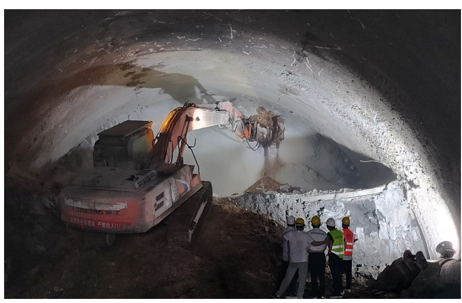
5月22日上午,荷叶村隧道内,施工人员进行隧道贯通作业。刘波 摄
