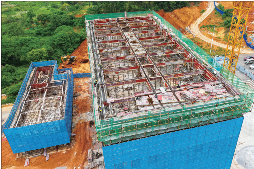
5月14日,在邵东市应急消防培训中心一期项目现场,施工人员正在有序作业,稳步推进项目建设。该项目建成后,将满足该市消防救援大队灭火与应急救援体能技能训练等需求,提高队伍整体战斗力及应急救援处置能力。李世近 摄
