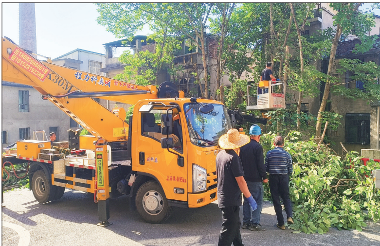
5月9日,双清区东风路街道通衡街社区接到群众反映:一棵梧桐树长在居民家墙角边,对房屋结构安全构成严重威胁。该社区迅速响应,逐户走访周边受影响住户,耐心沟通砍伐事宜,同步联系专业绿化施工团队,制订科学砍伐方案。图为5月13日,专业施工团队严格按照操作规范对隐患梧桐树进行砍伐清理,切实保障居民居住安全。邵阳日报记者 易蓝 通讯员 马静 摄影报道
