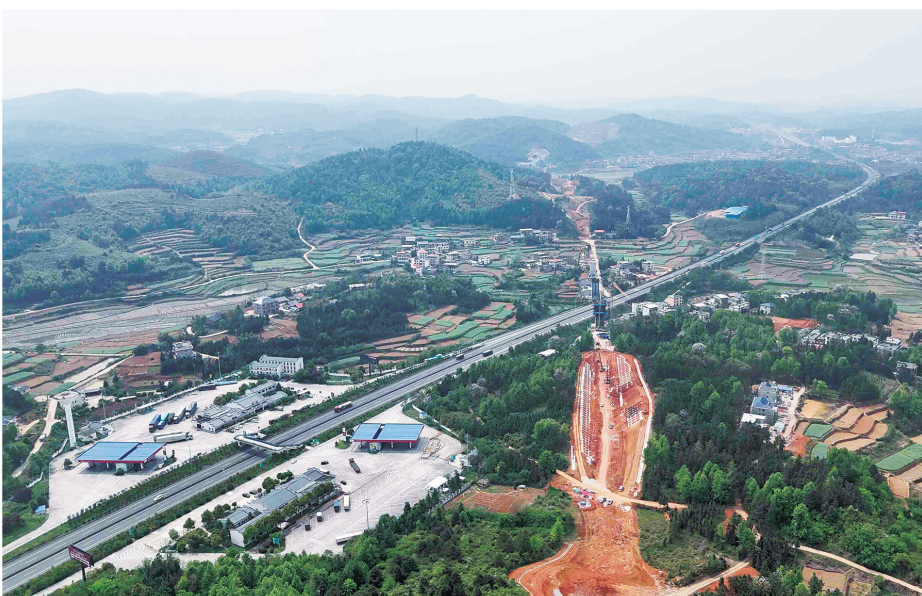
4月12日,邵永铁路重难点控制性工程——合志亭特大桥连续梁0#块现浇箱梁顺利完成浇筑。 王萍 摄
