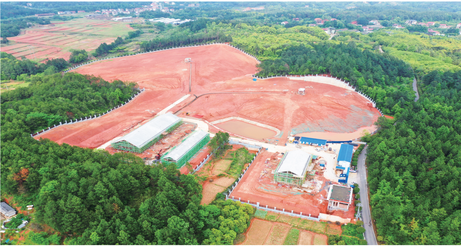
▲位于双清区火车站乡莲荷村的湖南省新闻出版广电局邵阳中波转播台迁建项目施工现场。
