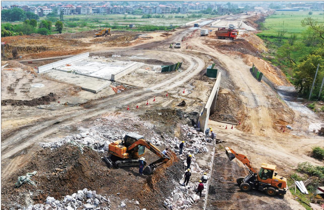
4月16日,东城快线邵东段施工现场热火朝天,施工人员正忙碌作业,确保项目早日完工。据了解,东城快线起于沪昆高速邵阳东收费站,止于邵东市绿汀大道,路线全长约18.5公里,道路按双向6车道设计,设计车速为80公里/小时,总投资约18亿元。 李世近 摄
