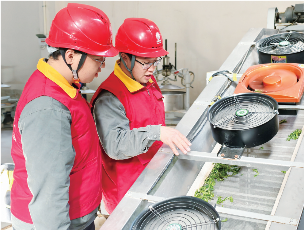
电力公司工作人员检查茶企电力设备。
