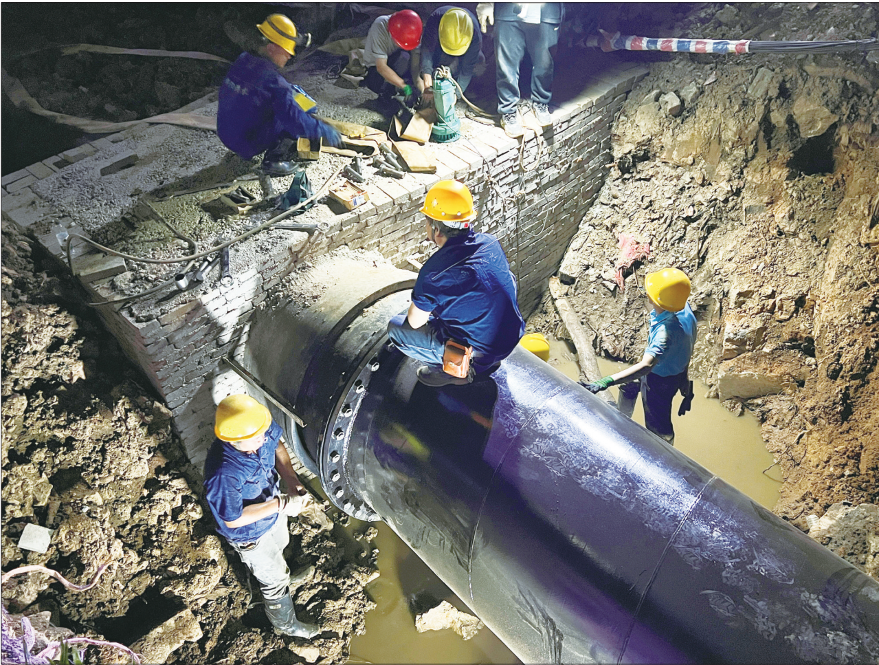
为配合邵永铁路建设,继去年完成学院路DN1200供水管道迁改工程后,市自来水公司再次启动桂花渡水厂两条出厂管道的迁改工作。图为4月18日22时,市自来水公司维修、安装人员按计划对桂花渡水厂1号出厂管马鞍石段进行停水断管作业,为供水管道迁改作准备。 邵阳日报记者 易蓝 通讯员 赵晋 摄影报道
