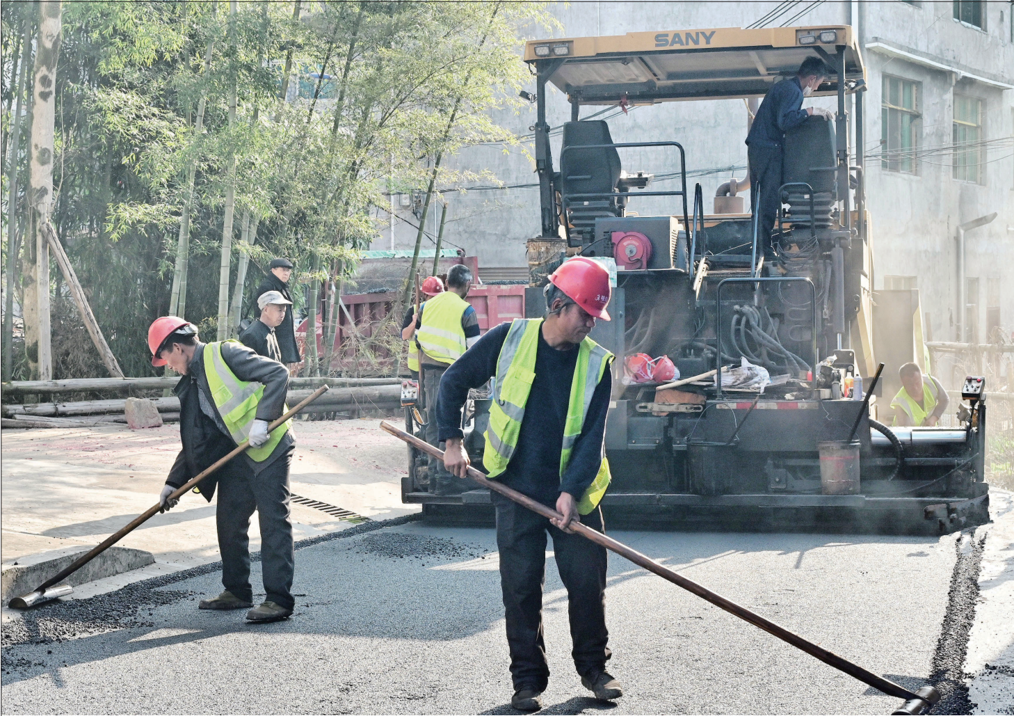
3月2日,隆回县金石桥镇黄金井村正在对聚和产业路进行提质改造。近年来,该村在省公路事务中心驻村工作队的帮扶下,对村内道路等基础设施进行改造升级,为乡村振兴注入了新的活力。 贺上升 摄
