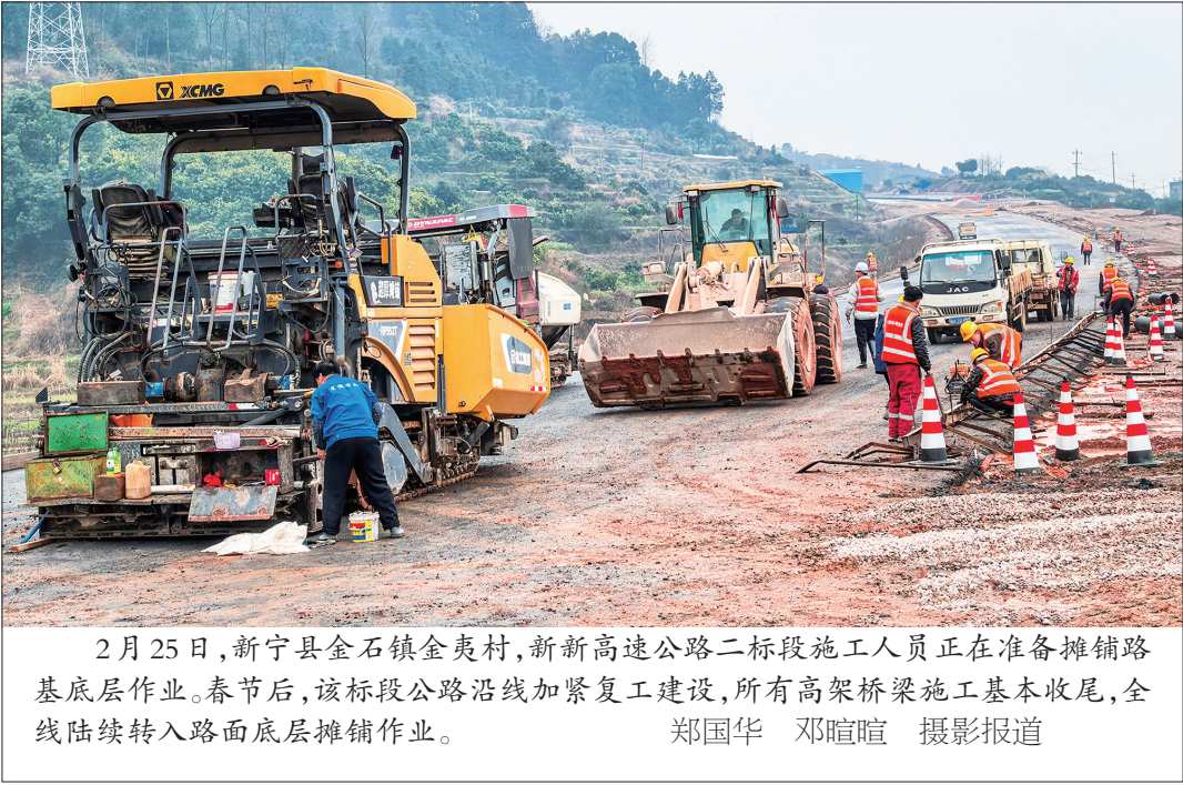
2月25日,新宁县金石镇金夷村,新新高速公路二标段施工人员正在准备摊铺路基层层作业。春节后,该标段公路沿线加紧复工建设,所有高架桥梁施工基本收尾,全线陆续转入路面底层摊铺作业。
