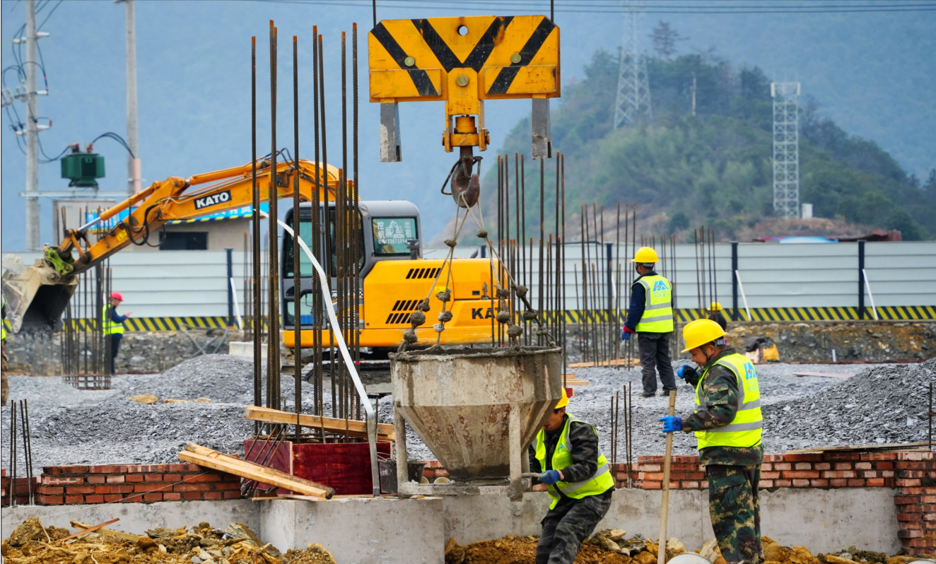
2月5日，绥宁县重点建设项目关峡竹制品循环产业园施工现场一派热火朝天的繁忙景象，开启了新一年的建设新篇章。 孙芳华 向海 陈代科 摄影报道
