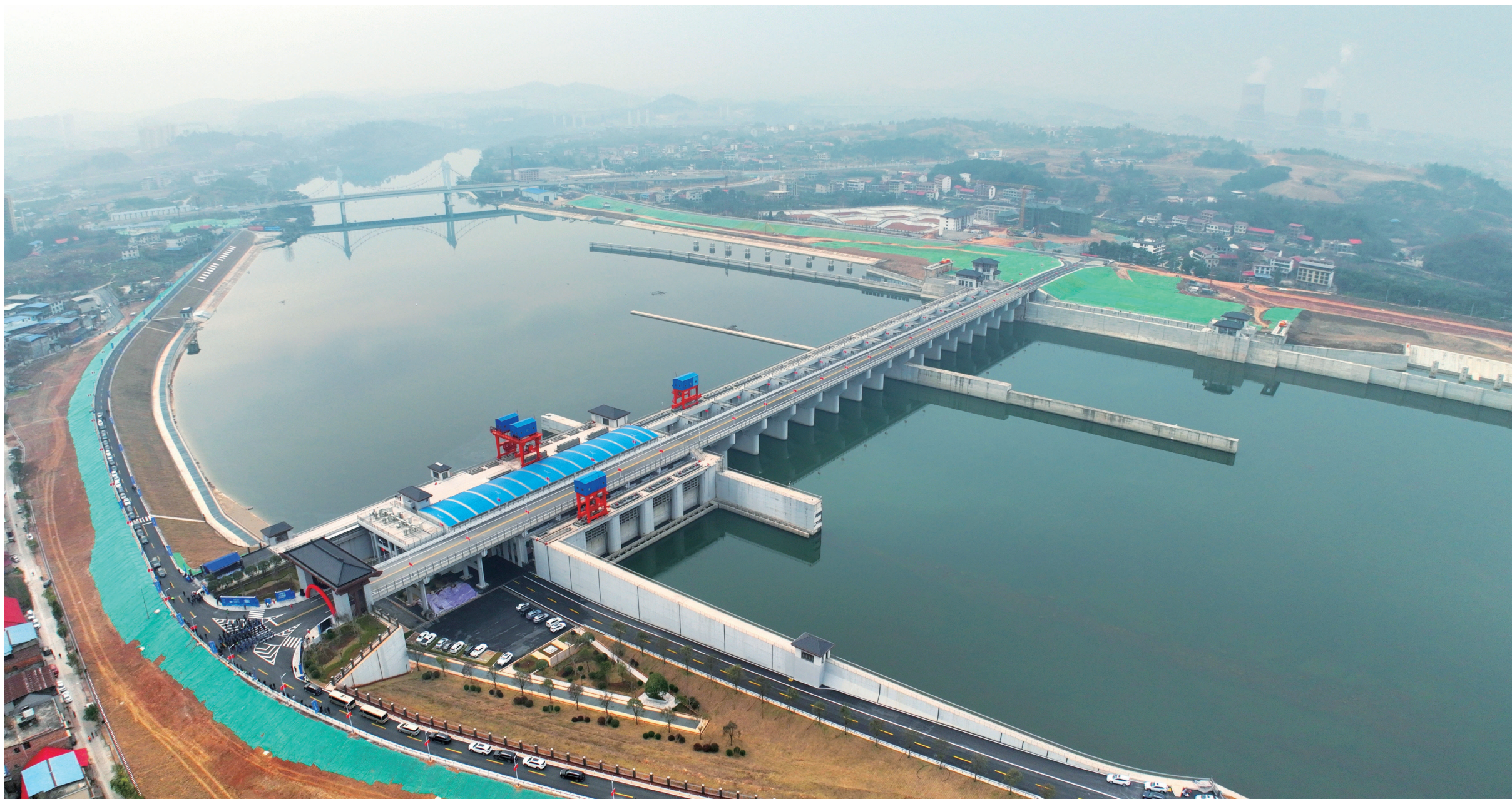
犬木塘水库枢纽工程坝顶公路桥远观。
