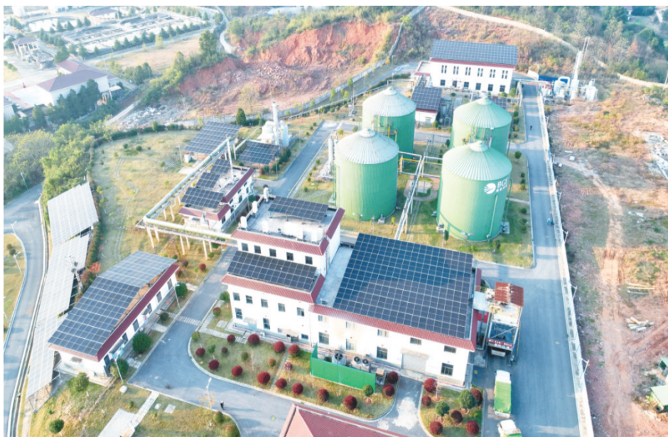
▲邵阳市污泥集中处置中心建设的光伏发电项目。
