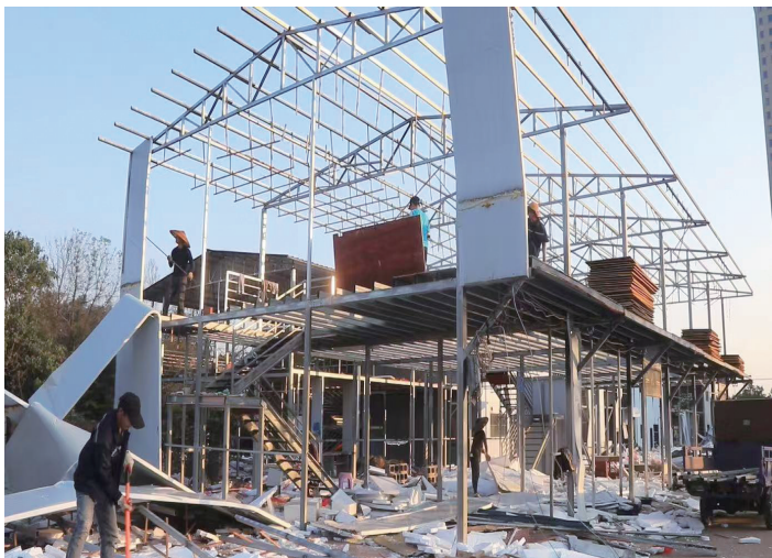
邦盛社区已完成搬迁,正在拆除违章过渡棚。
