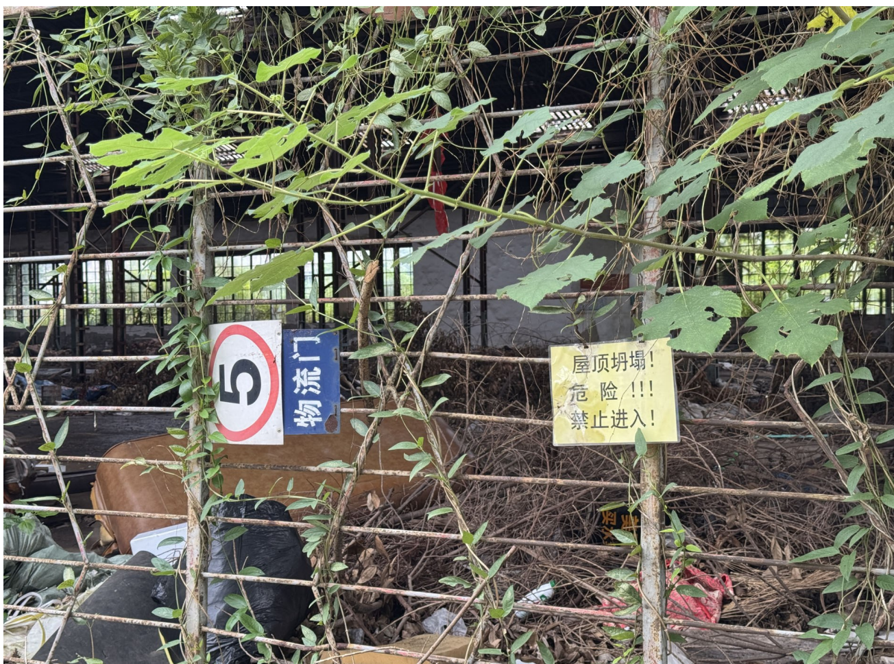
▲南宁手扶拖拉机厂的一些厂房外侧，设有警示牌。
