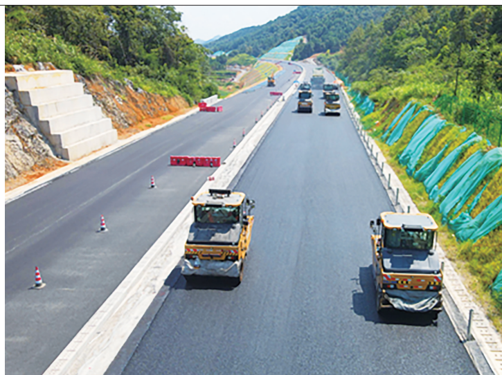
沥青路面摊铺施工现场。
