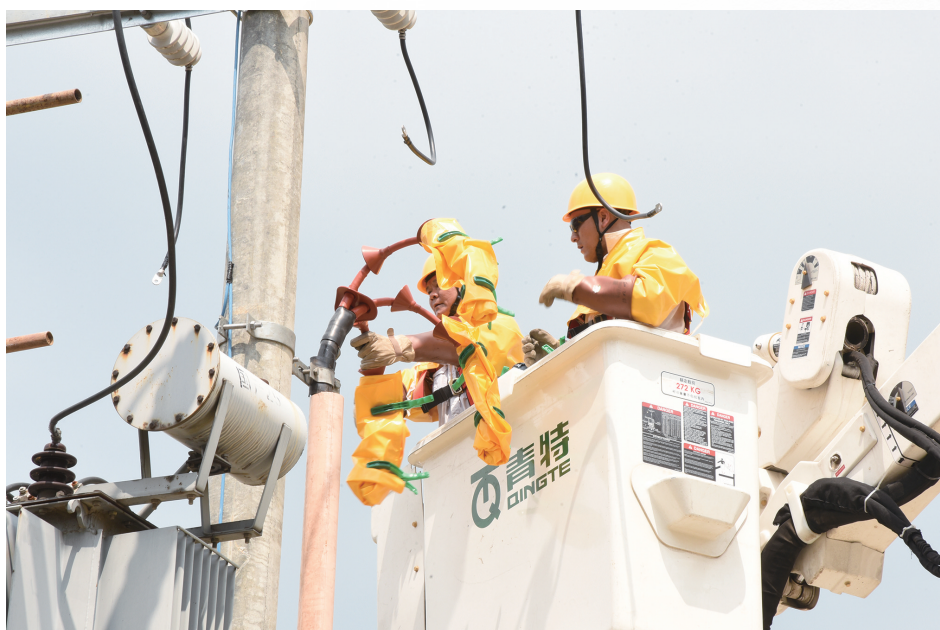
范建勋、左超华正在进行高空带电作业。
