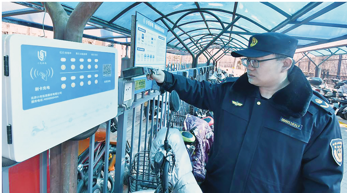
3月12日，安全生产检查人员在检查北京市大兴区天官院街道居民区内的电动自行车充电设施。 新华社记者 李欣 摄
