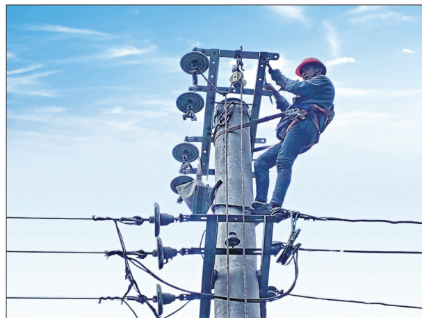
3月20日，在国网绥宁县供电公司10千伏城二线长铺站台区，工作人员正在进行改造工程施工，为地方经济发展提供坚强的电力保障。 杨萍 摄
