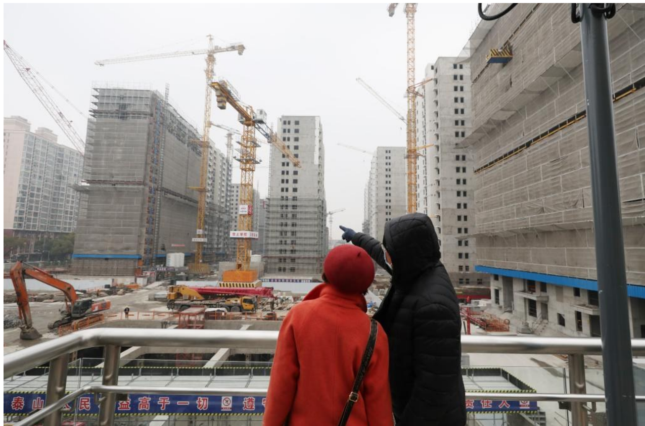
1月10日,两位市民在彭浦新村地铁站出站天桥上观看一建筑工地。
