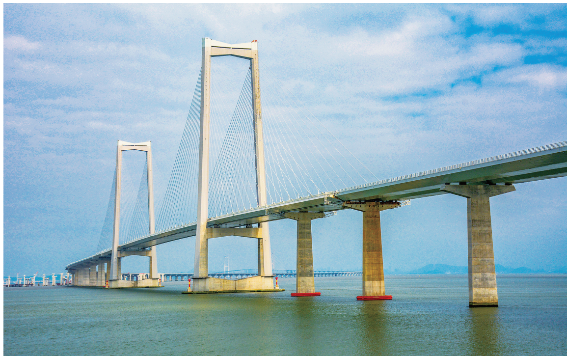
深中跨海大桥
