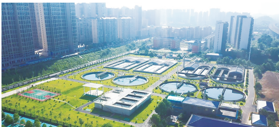
邵阳市红旗渠污水处理厂一角。
