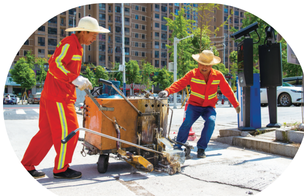
▲7月15日,14时50分,北塔区柘木社区新建的道路上,交通标识施工人员操控机器喷漆施划停车位。
