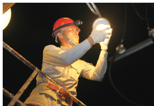
路灯管理所运维人员在检修路灯。
