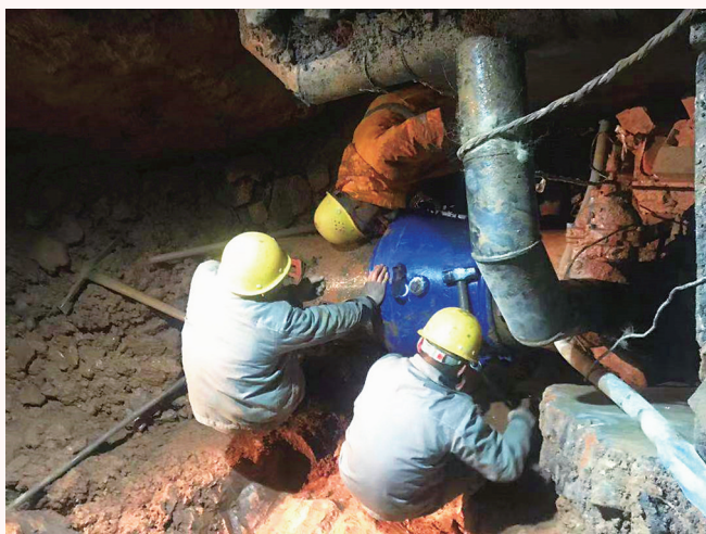
供水工作人员通宵抢修供水管道。
