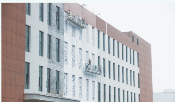
12月6日,东盟科技产业园里,工人正在粉刷外墙。
