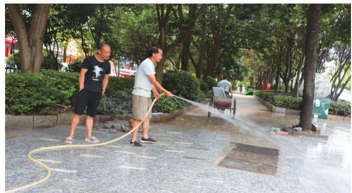
▲市政工人对新修建的人行道进行清洁作业。
