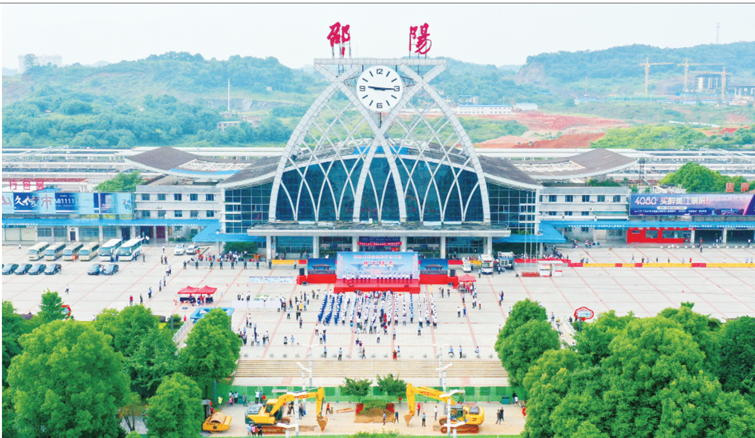
开工仪式现场。 申兴刚 摄
