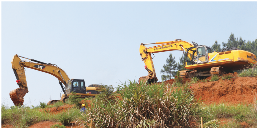
▲市餐厨废弃物资源化利用和无害化处理项目土方施工。
