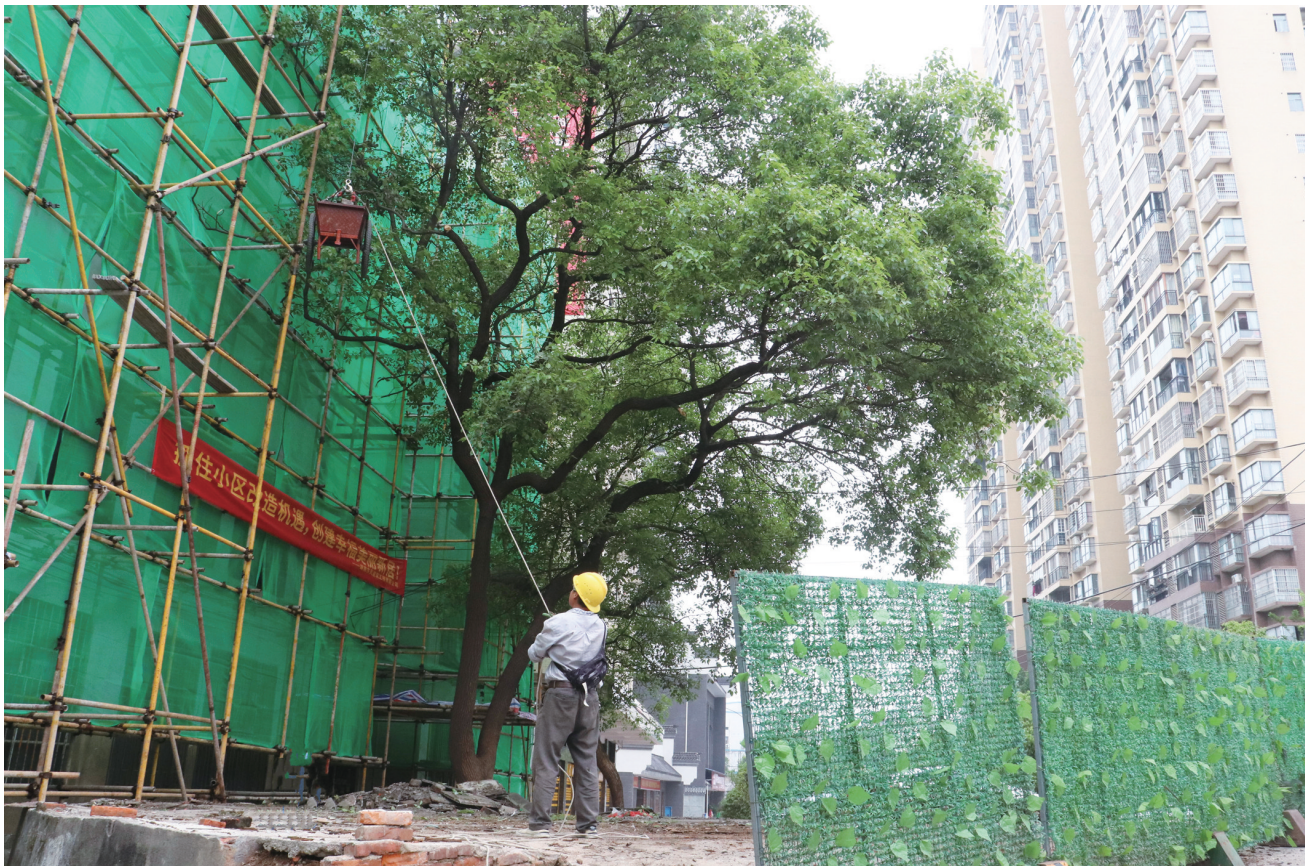
▲仪表厂家属区改造施工现场。
