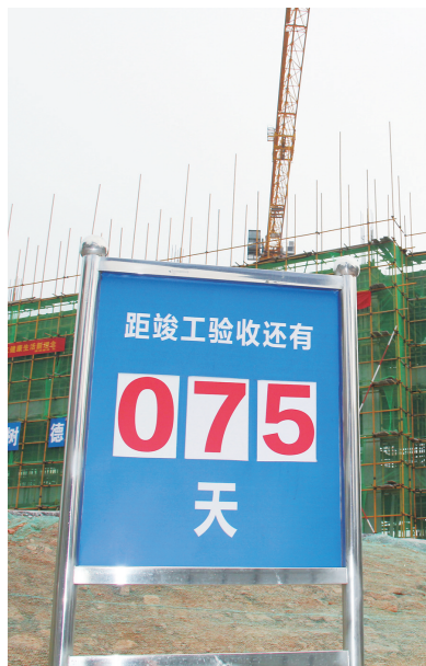
醒目的竣工验收倒计时提示牌。
