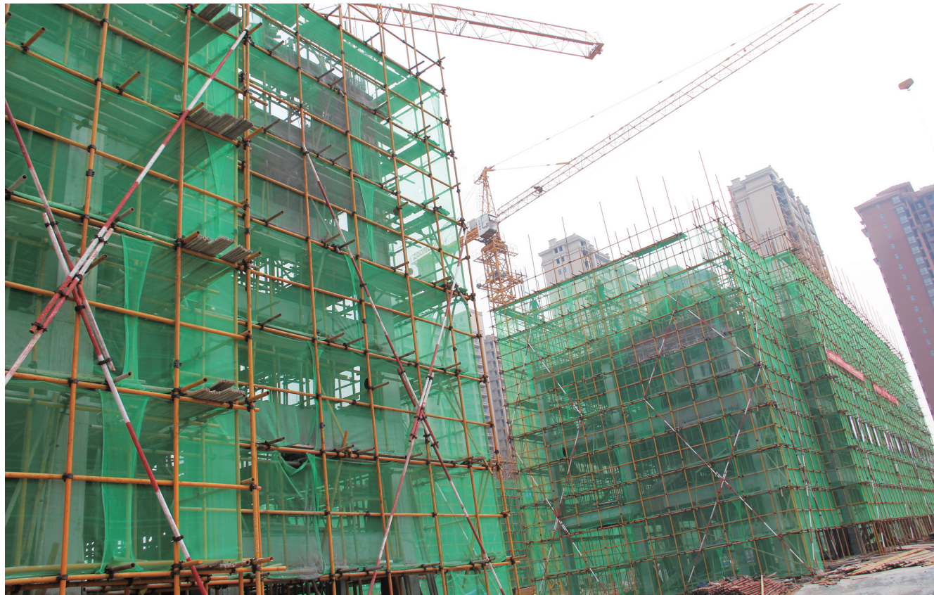
北塔区芙蓉学校一期工地。
