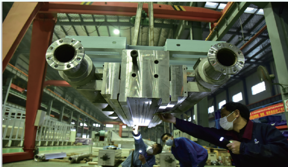
仪征化纤项目主机设备全部安装调试就位。
