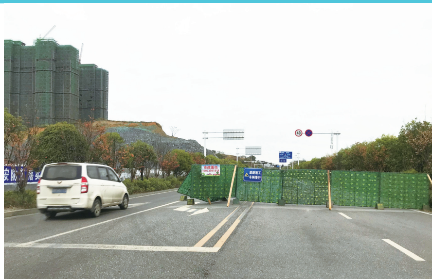
施工路段预留了通行车道。
