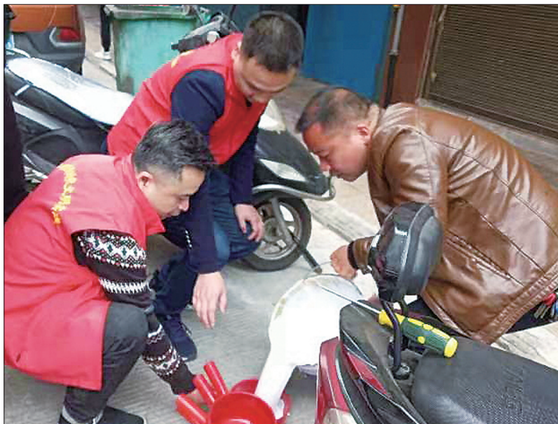
社区工作人员准备粉刷老旧及破损楼道墙壁。
