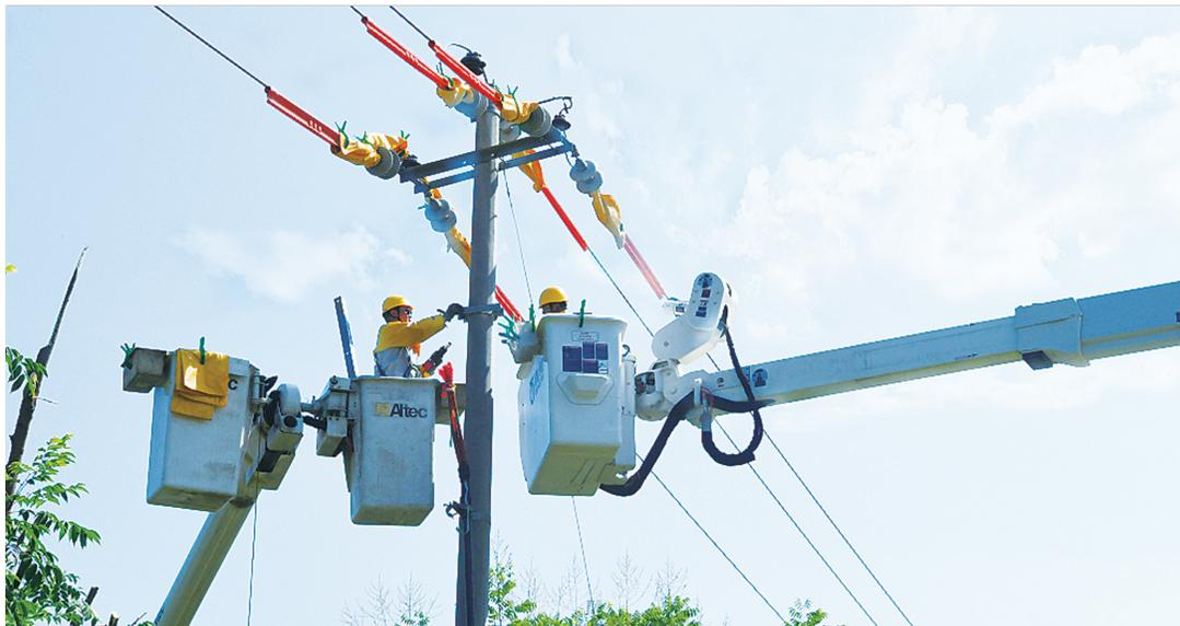
电力工人在电杆上进行带电检修。
