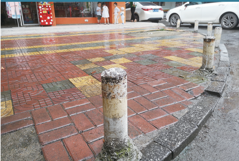
商家在店铺外围起了水泥墩。
