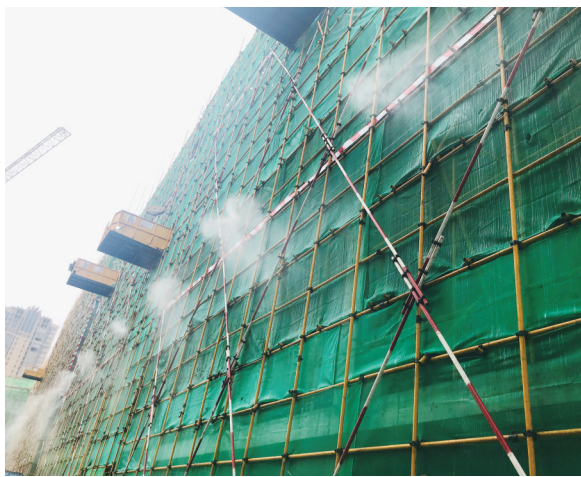
贴近建筑主体的脚手架喷淋系统。
