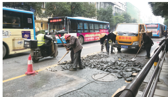
工人们在施工作业。
