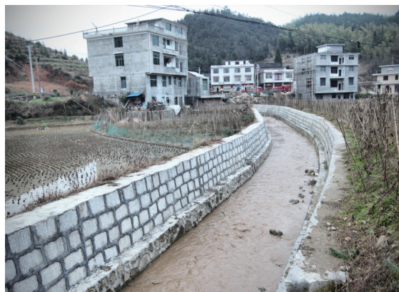
新建1200米农田水利渠道。
