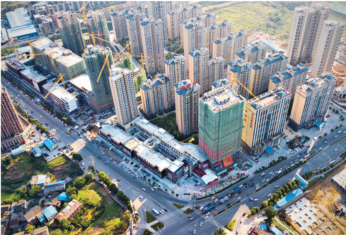
位于邵阳大道与建设南路交会处的志成新世界商业广场已经完工。
