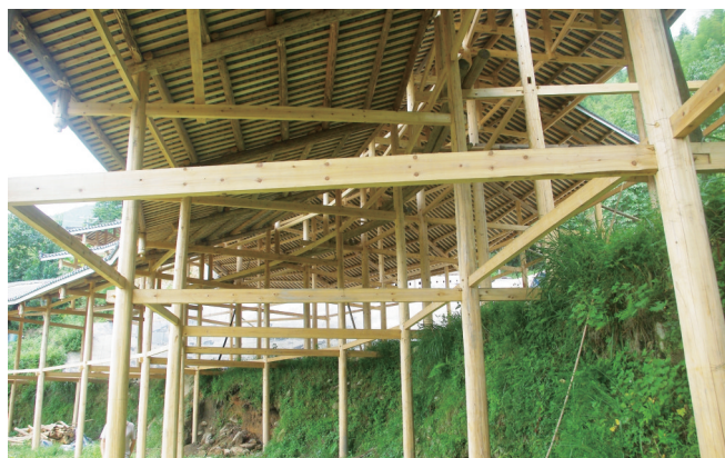
这座全木卯榫结构圆弧吊脚楼精心选料,木工技艺精湛。
