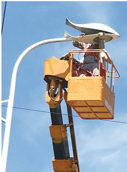
市路灯管理所工作人员在维修路灯。
