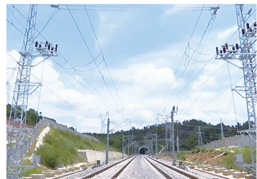
怀邵衡铁路四电工程
