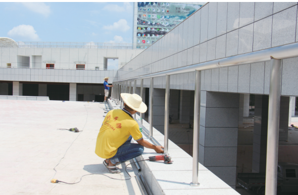
装护栏。工作人员正在市体育场外装护栏。童中涵 摄
