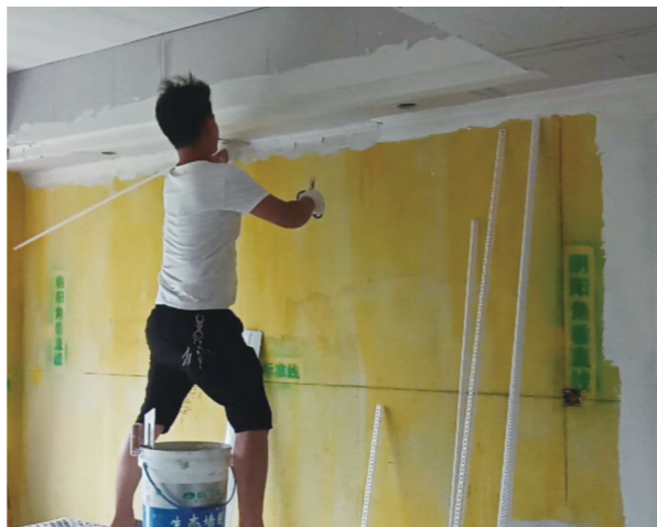
做墙面施工。随意居装饰公司师傅正在
