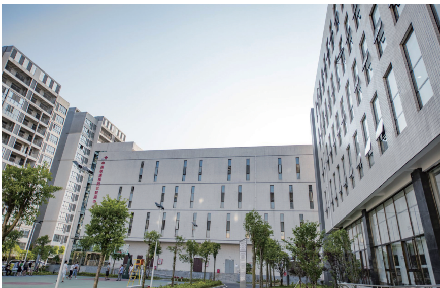
▲ 邵阳联通办公大楼及中国联通邵阳云数据中心
